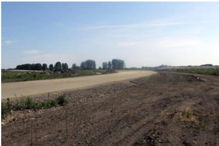
Die aufwendigen Arbeiten am Unterbau sind in weiten Streckenabschnitten fertig, in Kürze wird die erste Asfaltschicht aufgebracht.
